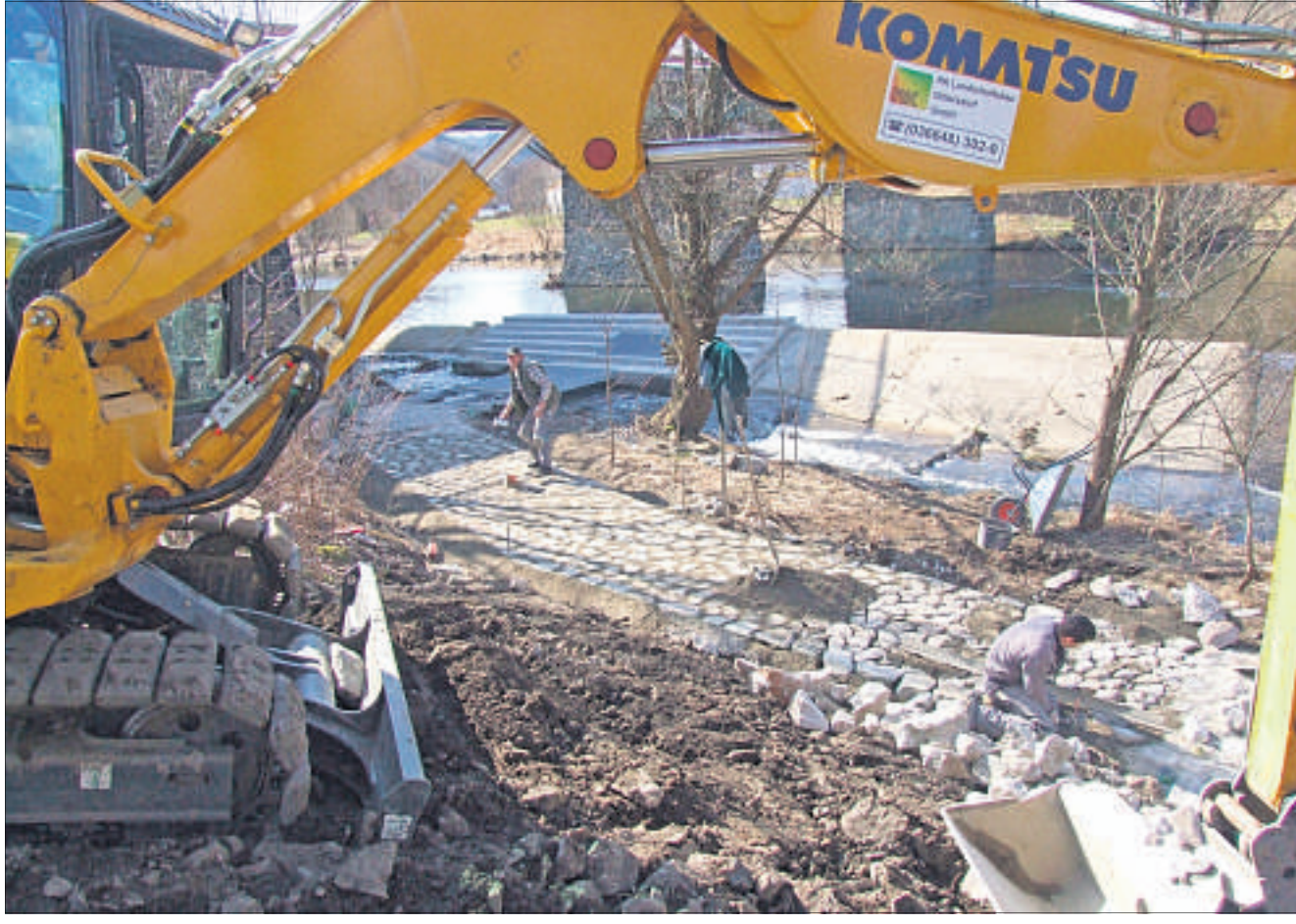
Bauarbeiten für den Ein- und Ausstiegsbereich am Blankensteiner Saale-Wehr.
